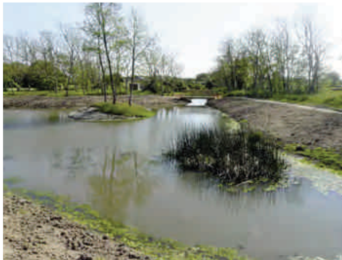
↑ Vue du nord, vers l'îlot aux 3 Aulnes et l'émissaire, en fin de creusement du bassin. Les joncs au premier plan ont conservés de la mare d'origine, avec leur microfaune naturelle.
