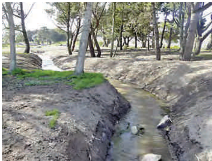
↑ La noue Noroit, juste après son creusement, en Mai (au fond, le Parking du Fogeo).
