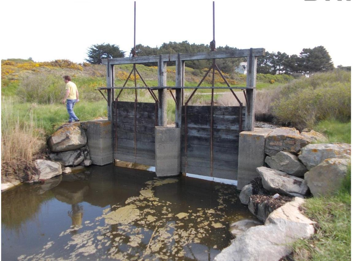
Figure 6-11 : Portes à la mer sur le site de Kerpont (Source : DHI)
