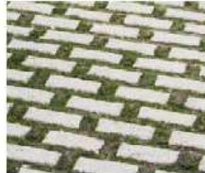
Pavage en béton avec ouvertures de drainage
