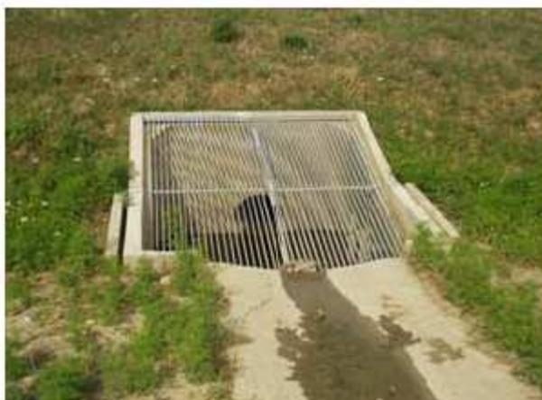
Grille de protection sur ouvrage de sortie
